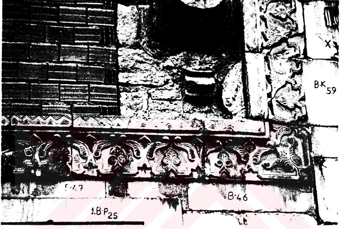
Resim 130 : Gök Medresenin avlusundaki saçak altında yer alan bezeme kuşağı.
