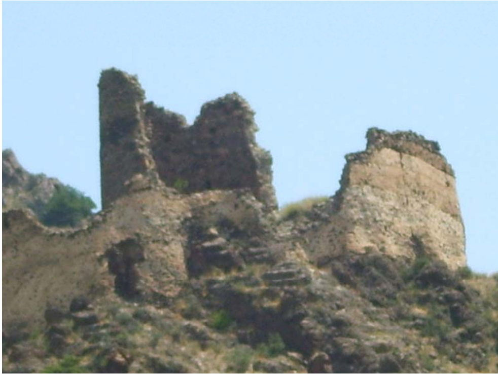
Figür 42-Olur-Köprübaşı Kalesi (Batı Cephesi)
