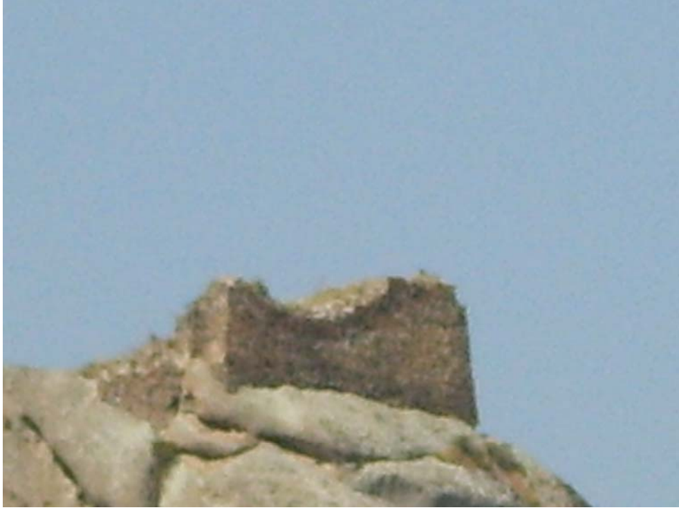
Figür 43-Olur Kalesi/Olur Merkez Kale (Güneybatı Cephesi)
