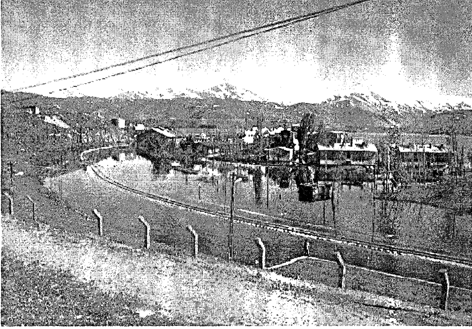
Foto 2.13. Göl Seviye Yükselmesine Bağlı Olarak 1994 Yılında Su Altında Kalan Demiryolu ve İdari Binalar.
