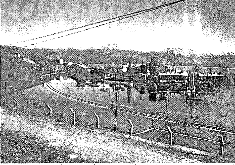
Foto 1.10. Feribot İskelesi ve İşletmeye Ait İdari Binaların 1994 Yılındaki Hali
