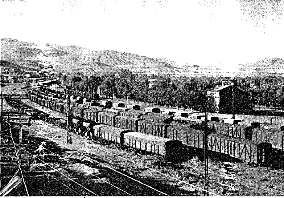
Foto 2.9. Türkiye – İran Demiryolu Hattının Doğu Anadolu'daki En Önemli İstasyonlarından Birisi Olan Tatvan İstasyonu.
